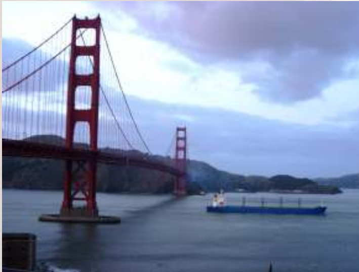
Un Puente Hacia la libertad
